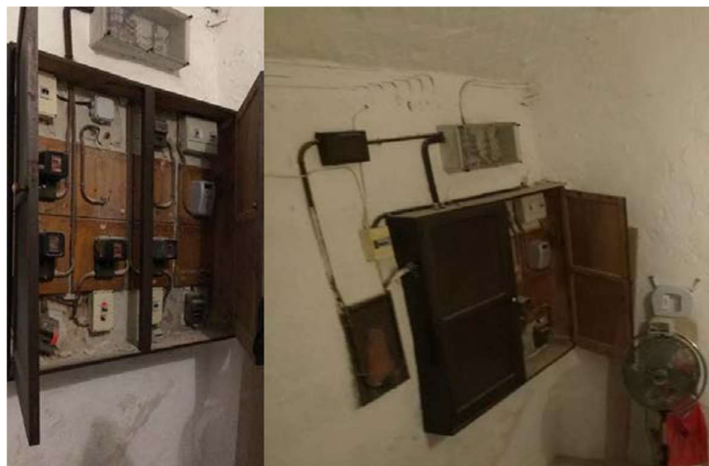
Imatges de l'estat actual del quadre elèctric.
