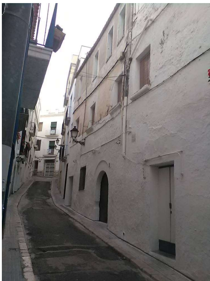
Edifici finca a c/ Tacó nº 5 (t.m. SITGES, Barcelona)
