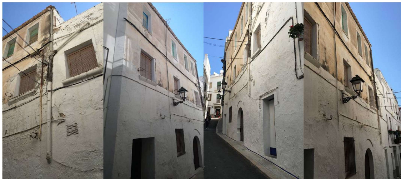
Imatges de la façana principal del carrer Tacó
