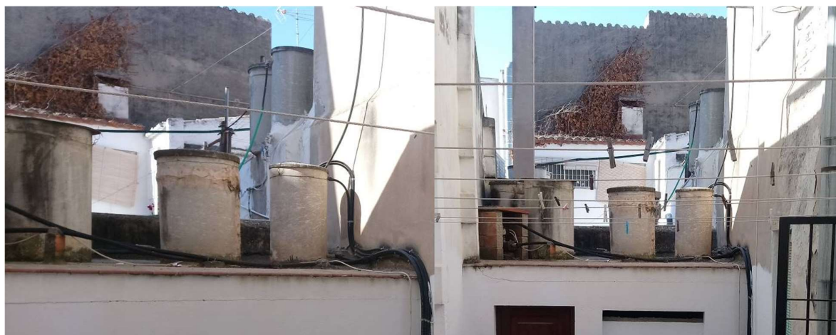
Imatges dels dipòsits d'aigua de fibrociment
