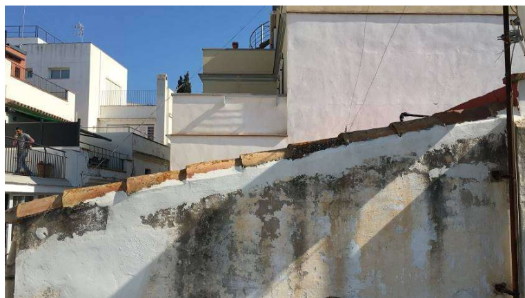
Imatge de la coberta presa des de la terrassa de la planta segona.
